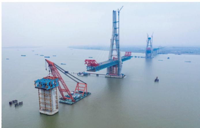
1月29日，沪通长江大桥27号辅助墩第3段节间钢梁吊装对接成功，标志着主航道桥墩顶钢梁架设施工全部完成
