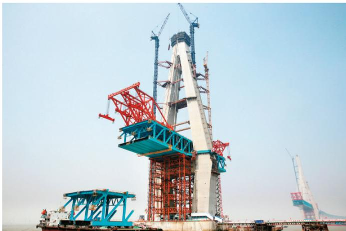
3月11日，世界跨度最大的公铁两用斜拉桥沪通长江大桥南主塔斜拉索挂设现场，2号斜拉索正在挂设中
